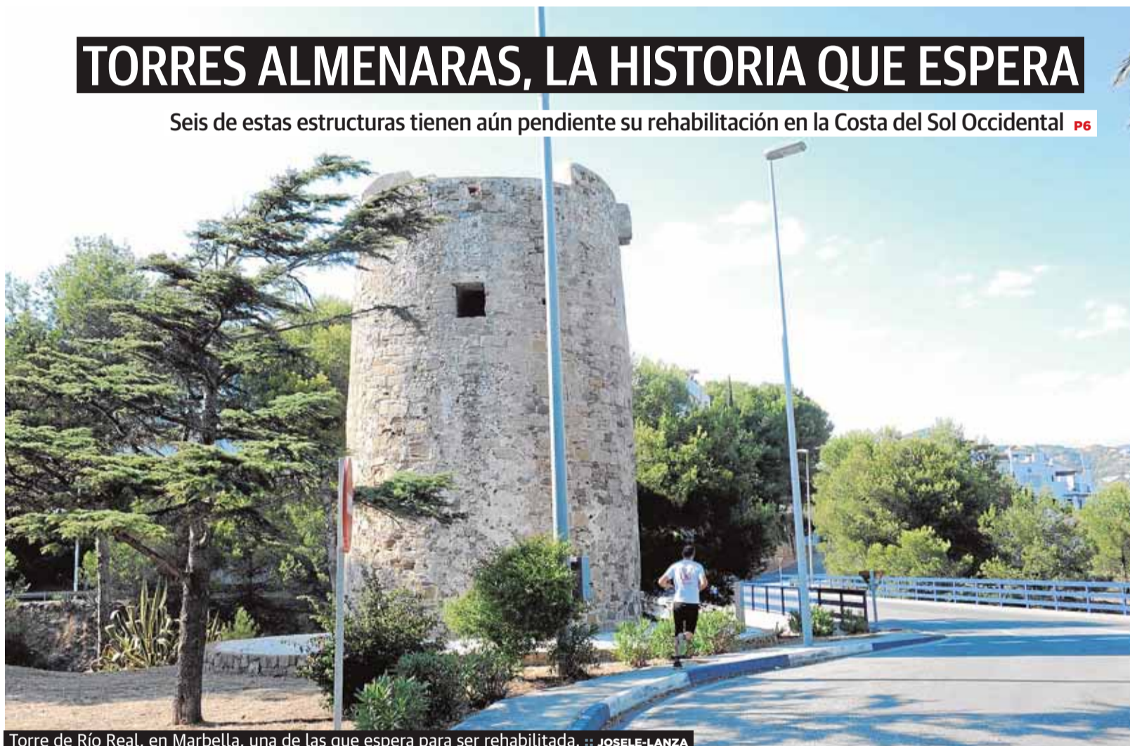
Torre de Río Real, en Marbella, una de las que espera para ser rehabilitada. :: JOSELE-LANZA
