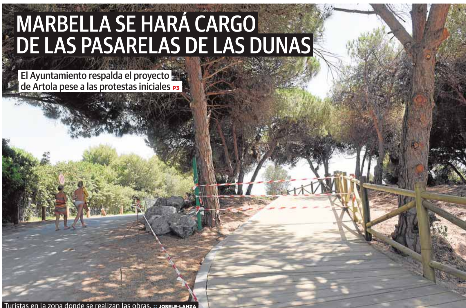
Turistas en la zona donde se realizan las obras. :: JOSELE-LANZA
