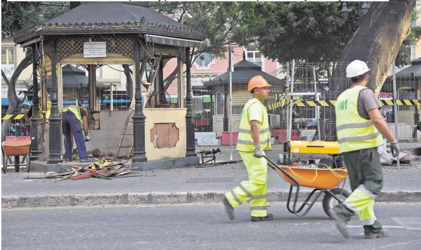
Operarios comenzaron ayer las labores de retirada y desmontaje del mobiliario urbano, como quioscos y marquesinas de la EMT. :: FRANCIS SILVA
