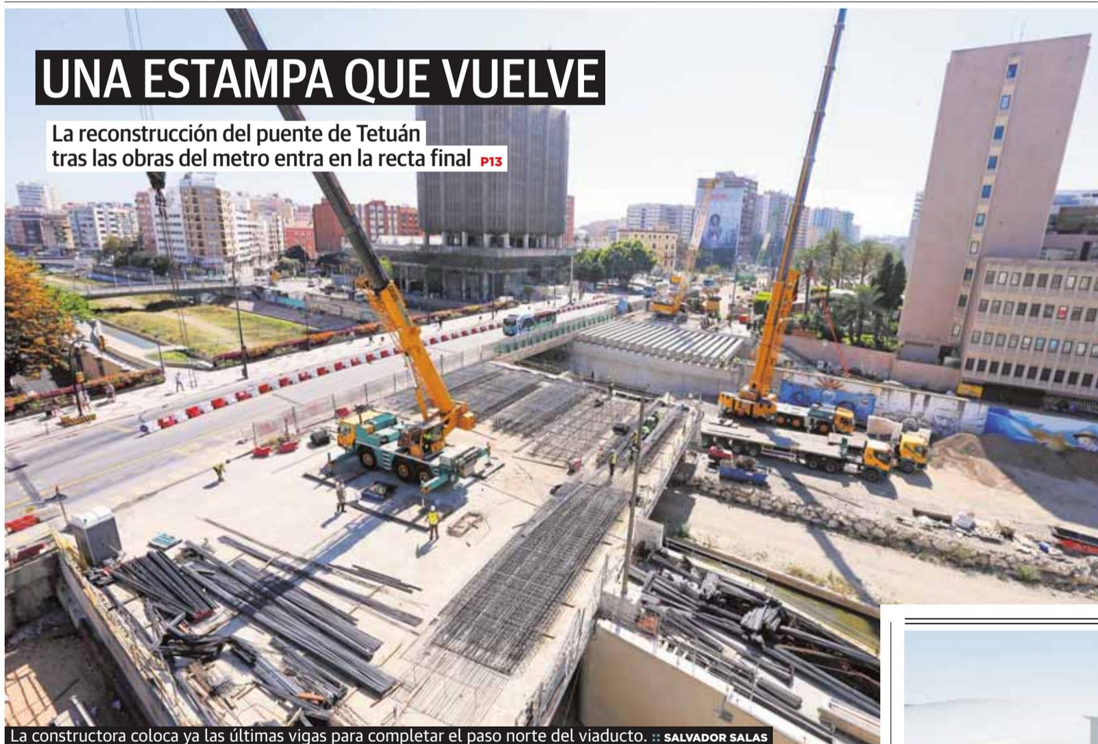
La constructora coloca ya las últimas vigas para completar el paso norte del viaducto. :: SALVADOR SALAS
