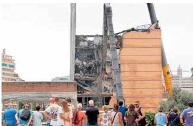
Curiosos presencian los trabajos de demolición. MIGUE FERNÁNDEZ
